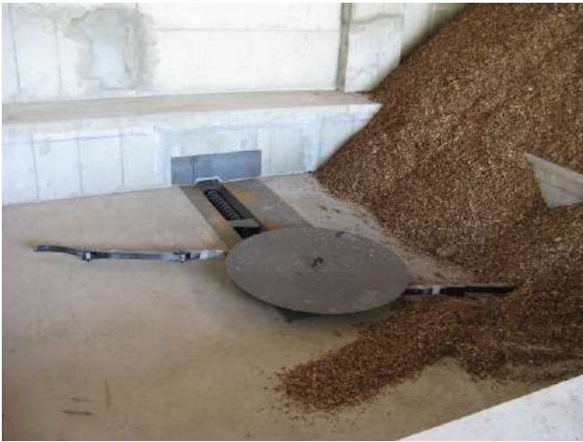
Départ de la vis sans fin d'alimentation côté stockage
