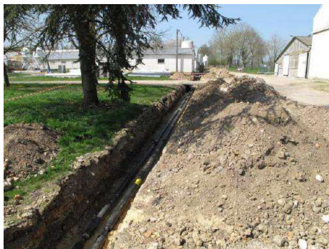
Tranchées pour les réseaux enterrés
